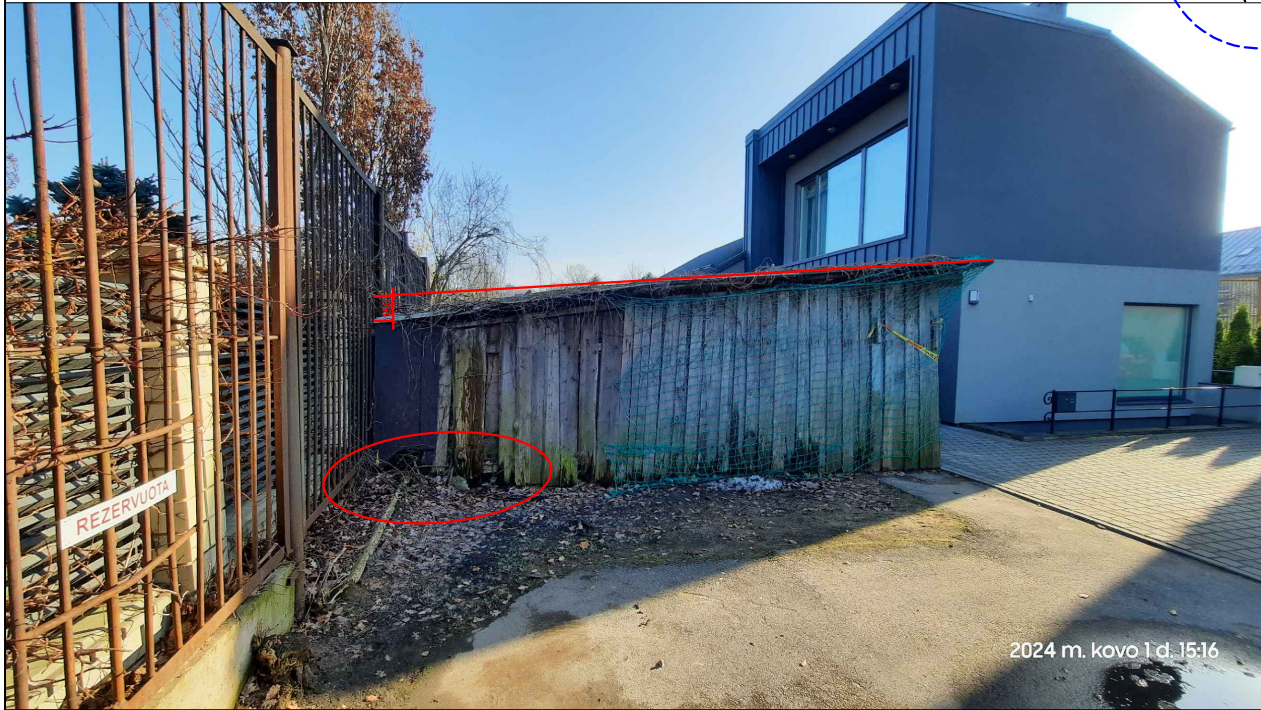
Susmėgęs pastato kampas 1-B, dėl to išsikraipęs pastatas
